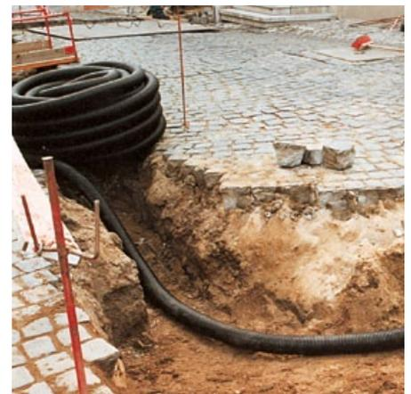
Bei der Verlegung um Kurven sind keine Bögen erforderlich. Problemlose Verlegung über längere Strecken ohne Unterbrechung
