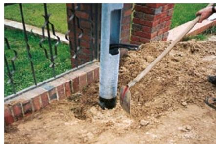
Abschließend Auffüllen und Verdichten des restlichen Zwischenraumes um Furowell mit anstehendem nichtbindigem Boden und Auftragen der Deckschicht.
