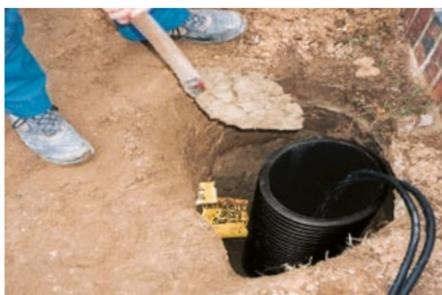
Sichern des Fundamentrohres Furowell von außen durch Stampfbeton bis in die Höhe des seitlichen Kabelanschlusses. Danach Einbringen des Beleuchtungsmastes.
