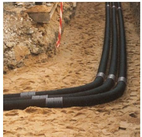
Bögen von 45° und 90° ermöglichen eine einfache, kostengünstige Richtungsänderung. Größere Radien werden durch die Biegefähigkeit des Rohres bewältigt
