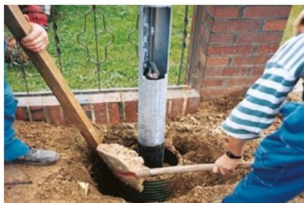
Anschließend Verfüllung des „Ringraumes“ im Fundamentrohr mit Sand. Oberen Bereich des Ringraumes mit Stampfbeton zur seitlichen Arretierung und zur Verhinderung von Wassereintritt verfüllen.
