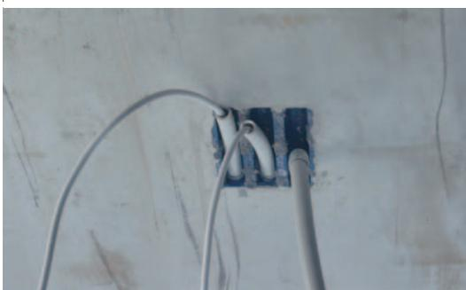
▲ Problemloser Übergang von Leitungen aus der Decke in darunter zu erstellende Leichtbauwände.
