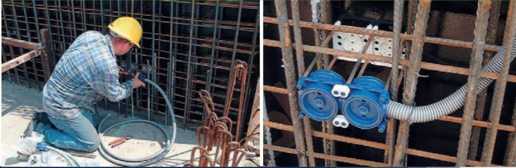
◀ Werkzeuglose Kombination der Gerätedosen. Patentierte Stützholztechnik ermöglicht bei jeder Wandstärke eine sichere und stabile Montage.
