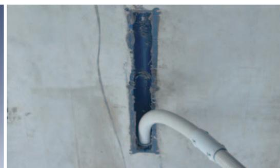
▲ Sichere und schnelle Weiterverbindung mit dem Rohrverbinder.
