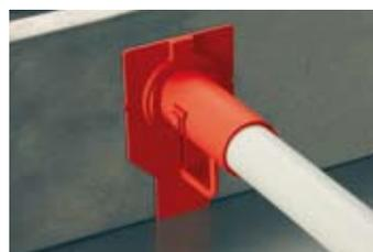
Зафиксируйте переходник «стена-потолок» точно на краю опалубки.
