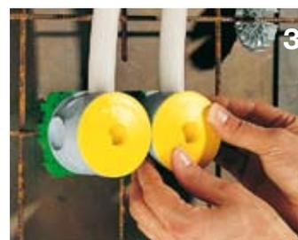
3. Соедините заднюю часть с трубой или кабельным каналом на фронтальном элементе и затем забетонируйте соединение.
