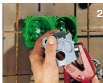
2. Создайте подвод для трубы или кабельного канала (пробойником или фрезой).
