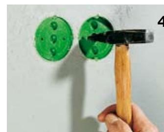
4. Откройте коробки или ящики бетонной конструкции, после этого установите устройства или крышки.
