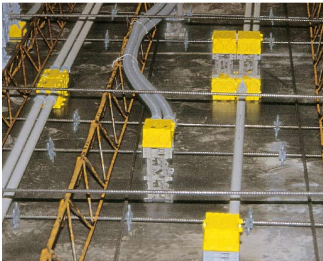
**За одно действие** с помощью муфт для труб системы В<sup>2</sup> можно открыть ответвительную коробку и одновременно закрепить муфту. В два счета создается герметичное и надежное соединение между коробкой, муфтой и трубой (жесткой или гибкой). На эти переходы не влияют ни низко-, ни высокочастотные колебания.
