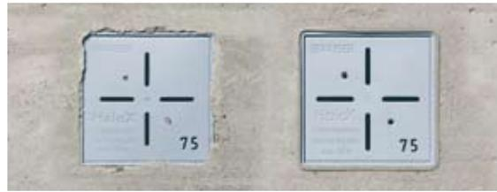
При работе с облицовочным бетоном фронтальные элементы с эластомерным уплотнением обеспечивают потолочные вырезы с резко очерченными контурами.
