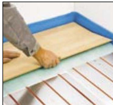
Положите подложку деревянного настила поверх пластин T2Reflecta и после этого уложите новый пол из дерева или ламината в соответствии с инструкциями производителя.
