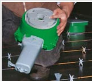
HaloX-P-Gehäuse mit Montageplatte auf dem Schaltisch mit mind. 4 Klebefolien (1219-00) fixieren.
