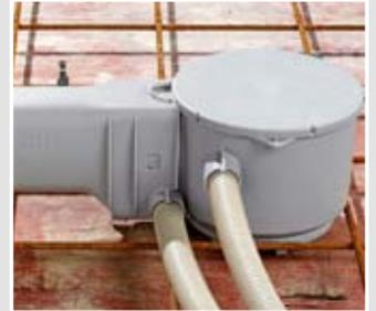
Fertig installiertes Gehäuse eventuell noch mit Rödeldraht an der Bewehrung sichern.
