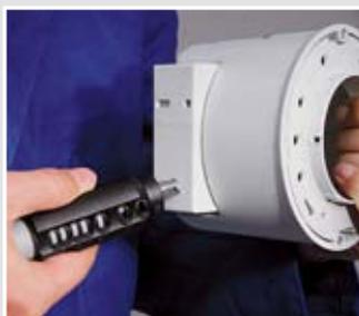
Die Öffnung für die Leitungseinführung wird passgenau und luftdicht in der Trafokappe mit dem Universal-Öffnungsschneider erstellt.
