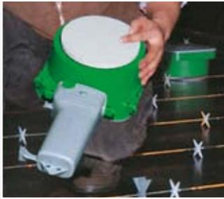
Montage im Betonwerk: HaloX-P-Gehäuse mit Mineralfaserplatte auf dem Schaltisch mit Heißkleber fixieren. Kleber an mind. 4 Stellen auftragen!
