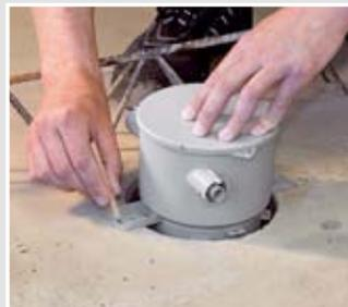
Gehäuse aufstecken und in die Kernbohrung setzen, anzeichnen und befestigen. Rohr in KSK-Einführung installieren.
