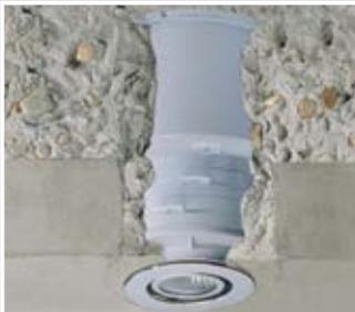
Für Plattenstärken über 50 mm kann das Gehäuse mit dem Verlängerungsring um je 10 mm verlängert werden.
