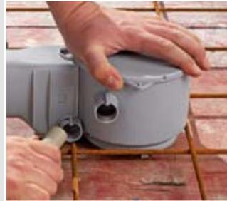
Rohre (Ø 20mm oder Ø 25 mm) bis zum Anschlag einführen.
