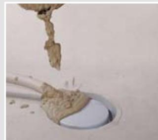
...der freie Raum wird mit Beton aufgefüllt und verdichtet. Das Auslaufen von Beton an der Unterseite verhindert ein untergesetztes Schallbrett.
