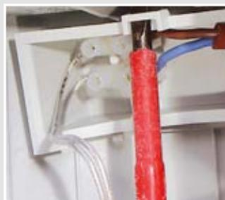
Mit einem Schraubendreher oder einer Spitzzange kann die Trafokappe auch nach dem Einbau herausgehoben werden, um den Trafo zu warten.
