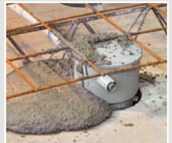
Das fixierte Gehäuse (eventuell mit Rödeldraht an der Bewehrung sichern) sitzt jetzt fest und passgenau.
