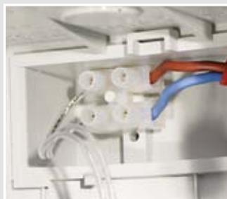
Festen Halt hat die Klemme in der Trafo-Verschlusskappe und wird so vor der Hitze der Lampe geschützt.
