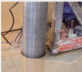
Kernbohrung (Ø 150 - 160 mm) in die Plattendecke schneiden.
