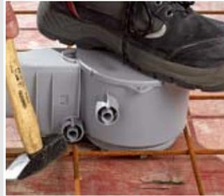
Gehäuse aufsetzen und die KSK-Kombieinführung mit einem Hammerschlag öffnen.
