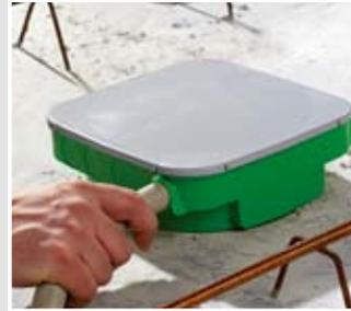
Rohre einführen und fertig betonieren.
