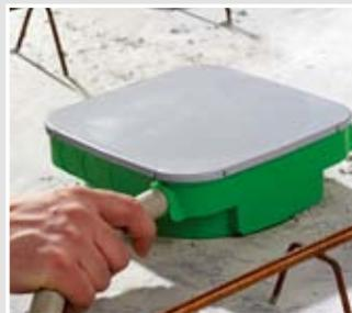
Rohre einführen und fertig betonieren.
