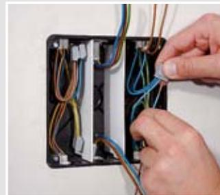
Mit einsteckbaren Trennwänden lassen sich mehrere Stromkreise sicher in einem Kasten trennen.
