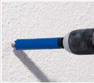
Einbauöffnungen Ø 20 mm erstellen (z. B. KAISER Hartmetall-Fräser Art.-Nr. 1088-06 mit Tiefenanschlag).
