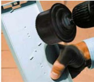
Sollten Sie keinen Universal-Geräteträger mit Kombieinsatz (1159-26) zur Verfügung haben, können Sie für den Einsatz von Gerätedosen die rückseitigen Markierungen für die Erstellung der Installationsöffnung nutzen.
