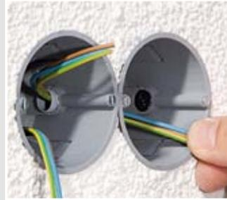
Die vollisolierte Durchverdrahtung erfolgt mit dem KAISER Verbindungsstutzen.
