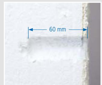
Die Dämmwirkung bleibt trotz Einbauöffnung erhalten.
