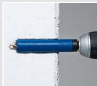
Durch die Bohrtiefenbegrenzung wird so viel Dämmmaterial entnommen, wie für die Befestigung des Mini-Geräteträgers benötigt wird.
