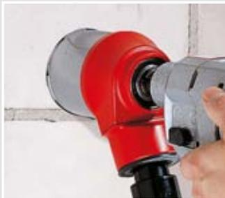
Passgenaue Wandöffnung (Ø 82 bis 84 mm) mit Diamant-Schleifkronen erstellen.
