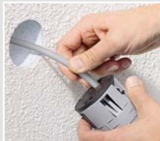
Die elastische Dichtungsmembrane der ECON-Technik fñgt sich beim Durchstoßen winddicht um die Leitung.
