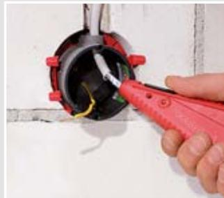
Mantel und Schirm der Leitung mit AMZ 2 entfernen. Blanken Beidraht mit transparentem Isolierschlauch versehen.
