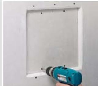
Beplankungsausschnitt (gem. Abb. 1) einfügen und am CW-Profil befestigen.
