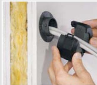
Dichtelement um die Leitungen legen und verschließen.
