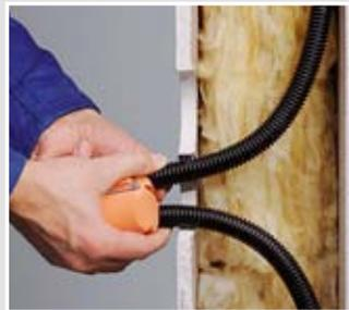
Leitungen bzw. Rohr mit leichter Drehung einführen. Zum einfachen Einsetzen der Dose, Faltpoden zur Mitte eindrücken.
