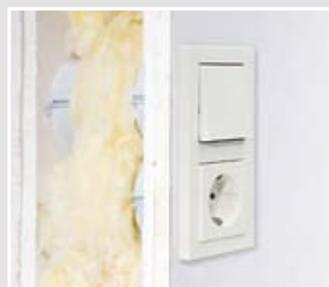
Einbaubeispiel mit einer Schalter-Steckdosenkombination.
