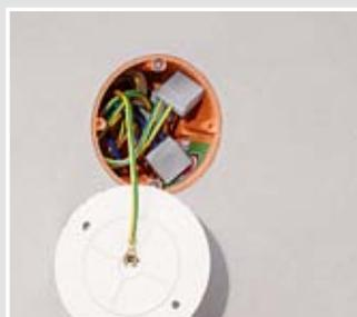
Als Verbindungsdose den Potentialableiter des Deckels mit den Beidrähten der Leitungen verbinden.
