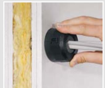
Dichtelement um die Leitung fügen, verschließen und durch eine 1/4 Rechtsdrehung fixie-ren.
