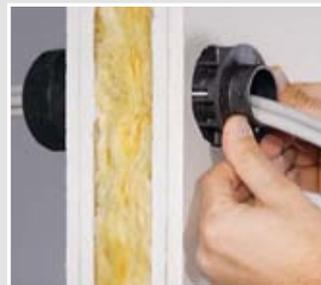
Einfaches Einsetzen des Schott-zylinders in die Installati-onsöffnung.
