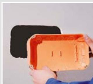
Einführungen ausbrechen, Leitungen einführen, Kasten einsetzen und mit den FX4 Schrauben befestigen.
