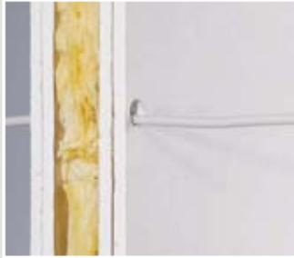
Installationsöffnung Ø 20 mm mit einem Fräser (z. B. KAISER-Hartmetallfräser 1088-06) oder einem Bohrer erstellen.
