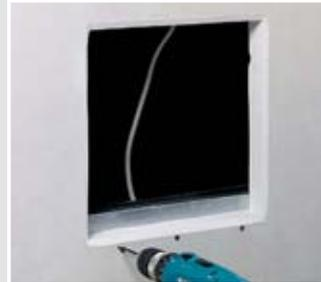
CW-Profil einfügen und mittels Schnellbauschrauben durch die Beplankung befestigen.
