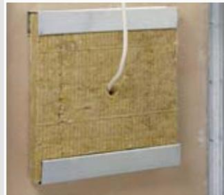
Hinterlegte Mineralwolle in CW-Profilen (Rückansicht).
