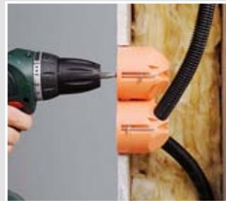
Beide Laschenschrauben der FX4 Schnellverschraubung anziehen.
