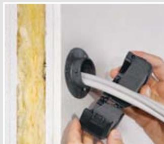
Dichtelement aufklappen und entfernen.
