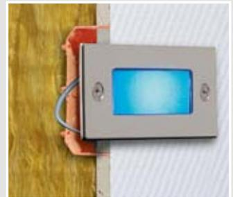
Tapezieren o. ä. und das gewünschte Gerät einbauen.
