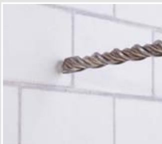
Installationsöffnung mit einem Ø 20 mm Bohrer erstellen.
