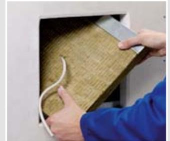
Zuschnitt der zu hinterlegenden Mineralwolle mit oberem CW-Profil in den Schacht einführen.
