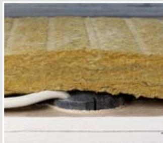
Mit Mineralwolle nach DIN 4102-17 hält die Installation einem Brand bis zur Feuerwiderstandsklasse F60 stand, mit Rockwool/Termarock 100 bis zur Feuerwiderstandsklasse F90.
