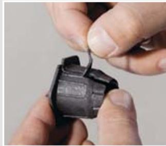
Abreiblasche für die Mauerwerksmontage entfernen (nur bei Rohrschotts in der Mauerwerksinstallation).
