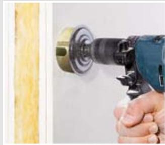
Installationsöffnung mit einem  $\varnothing$  74 mm Fräser (z.B. Multi 4000: 1084-10) erstellen.
