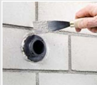
Schottzylinder mit Gips, Mörtel oder Schnellzement in die Installationsöffnung eindrücken und die Leitung durchführen.
