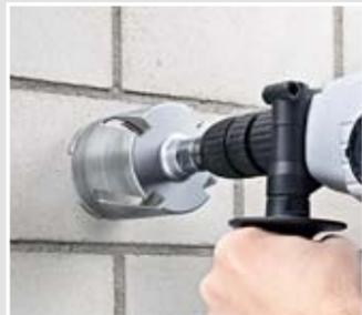
Installationsöffnung je nach Wandstärke mit einer 82 mm Diamant-Schleifkrone oder mit Kernbohrer erstellen.
