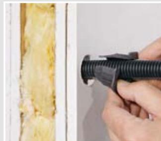
Durch das Aufklappen des Leitungsschotts, kann dieses einfach um Leitung oder Rohr gelegt werden.
