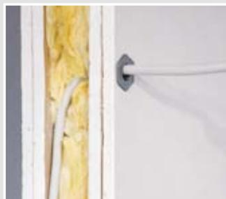
Wand Einführung in Trockenbau-Brandschutzwand.
