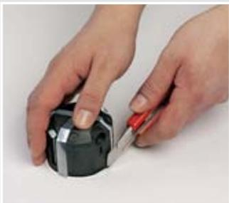
Die Kombination von Geräte-Verbindungs-dosen ist ganz einfach möglich. Nach Erstellung der Fräslöcher (74 mm) im Normabstand (71 mm) ist der markierte Bereich des Halterandes abzutrennen.
