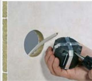
Die Belegung kann für max. zwei bzw. vier Einführungen bis Ø 11,5 mm sowie für schwer entflammbare Leitungen gemäß UL-VO erfolgen. Die Öffnung für die Leitungseinführung erfolgt mit dem KAISER-Universal Öffnungsschneider.
