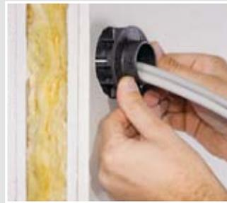
Schottzylinder in die Installationsöffnung eindrücken.
