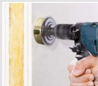
Mit einem Fräser (z.B. Multi 4000: 1084-10) wird eine Ø 74 mm Öffnung erstellt.
