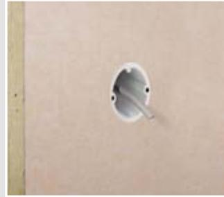
Hohlwanddose HWD B15 mit Laschenschrauben FX4 in der Wand montieren.
