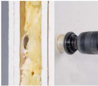
Installationsöffnung 35 mm z. B. mit dem KAISER-Fräser Multi 4000 (1082-10) erstellen.
