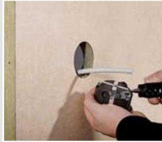
Leitungseinführung mit dem KAISER Universal-Öffnungsschneider öffnen.
