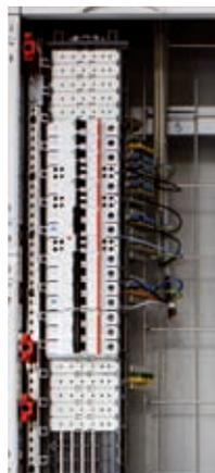
**Горизонтальные комбинированные комплекты** смонтированы на EDF-профили (той же высоты, что и высота панели)
